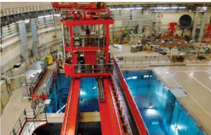
Im Wasser-Dampf-Kreislauf und im Brennelementlagerbecken kommt vollentsalztes Wasser zum Einsatz.
