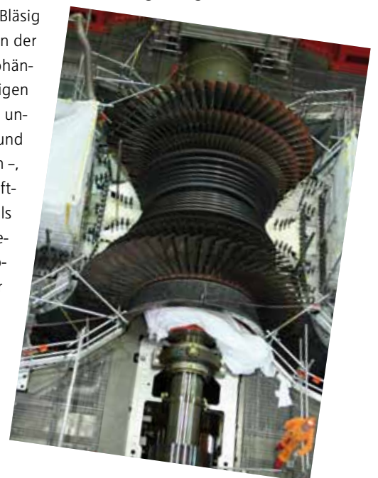
Generalüberholung der Primärwasserkühler zur Generatorkühlung (Foto l.); geöffnete Niederdruckturbine 2 im Rahmen der Revision (r.)
